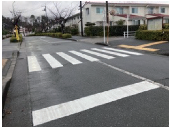
（小山田中学校前） 横断歩道の白線補修
