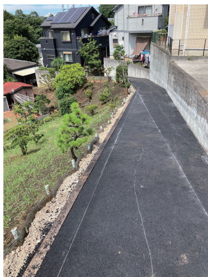
生活道路をアスファルト舗装(山崎町)
